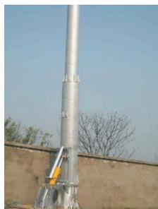
Um die Wartungs- und Betriebskosten zu minimieren werden die Windkraftanlagen standardmäßig mit einem hydraulisch kippbaren Masten ausgerüstet. Für Wartungs- oder Reparaturarbeiten sind somit keine Hilfsmittel notwendig.
